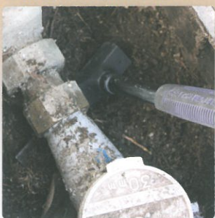
■配管下の掘削作業に
