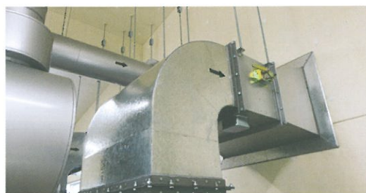
空調設備の吊りボルトに
