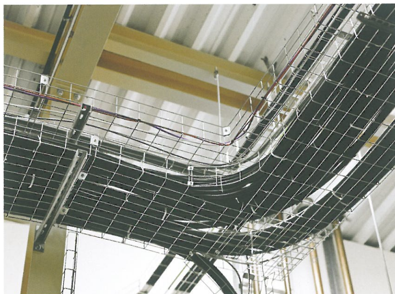
ケーブルラックの吊り込みに
