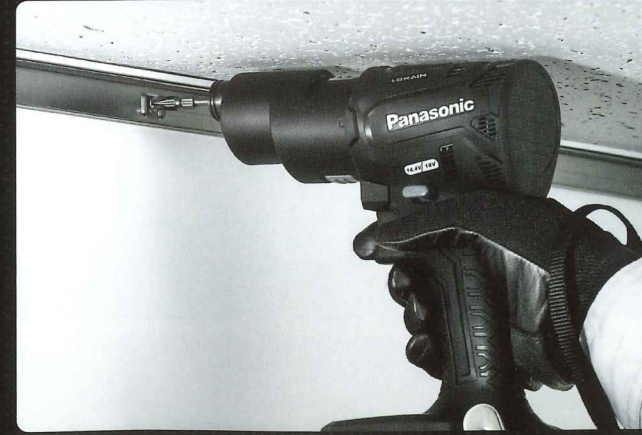
壁際のメタルモールの取り付け
