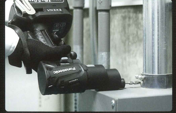
電線管の固定
