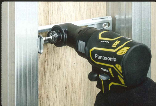
配線支持金具取り付け
