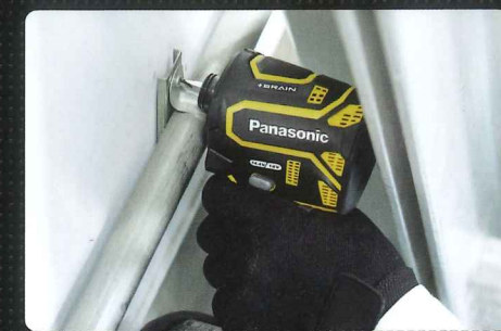
配管固定サドルの取り付け
