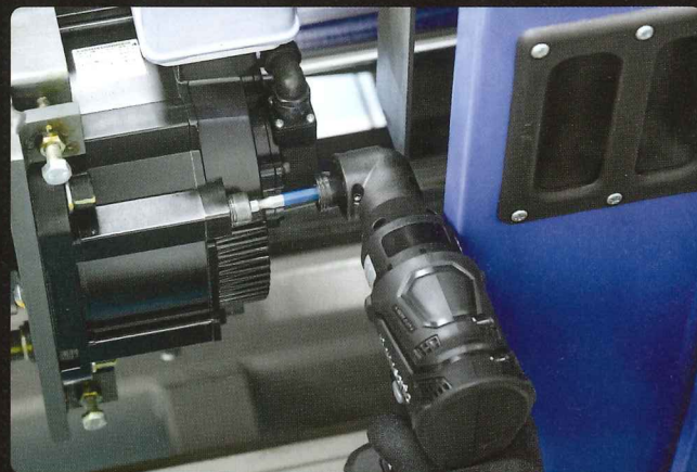
設備機械のネジ締め
