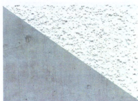
コンクリート・モルタル
