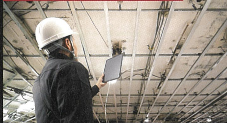
現場調査時にタブレットへ給電
