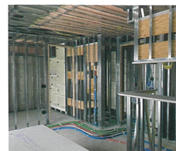
通電前の屋内作業に
