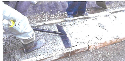
頭部のウラ面で生コン表面を綺麗にできます。
