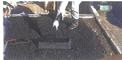
平らに均しやすいのでより仕上がった状態でレーキマンへ
